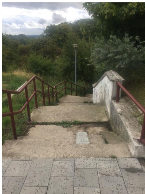
Rejon początku opracowania. Schody prowadzące od ul. Brygady Szczęrbca. Widoczny fragment nowej nawierzchni chodnika oraz zdegradowanej nawierzchni schodów przeznaczonych do remontu.
